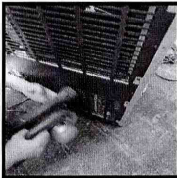
sopleteado de serpentín
